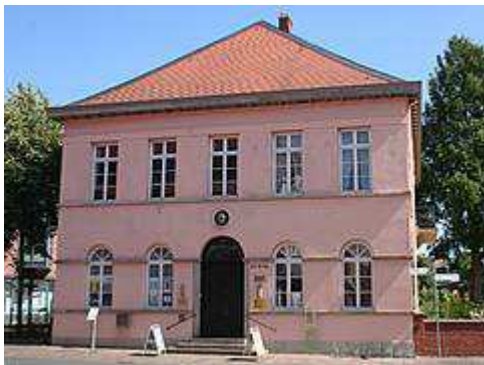
Das Quaet-Faslem-Haus in Nienburg
