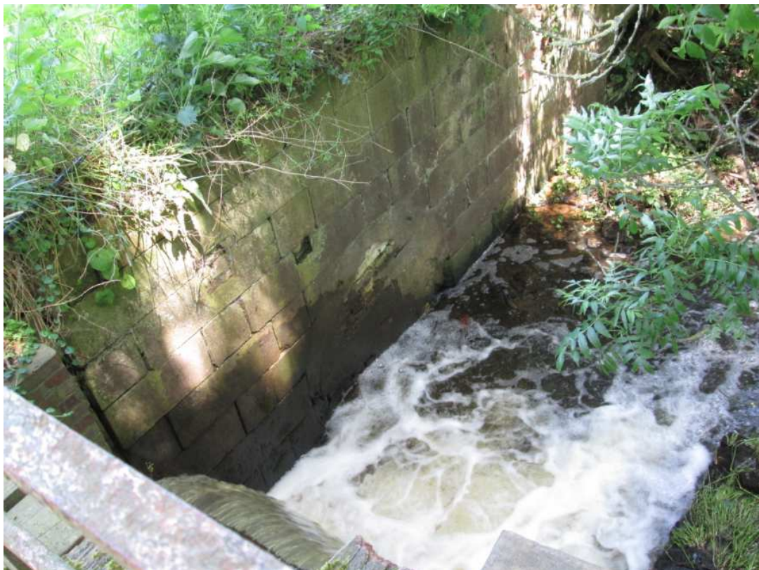
Nur das Wehr blieb von der Bunkemühle (Bild: Weigang)
