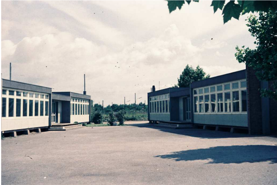
Die Baracken an der Eitorfer Straße standen von 1967 bis Januar 2017
