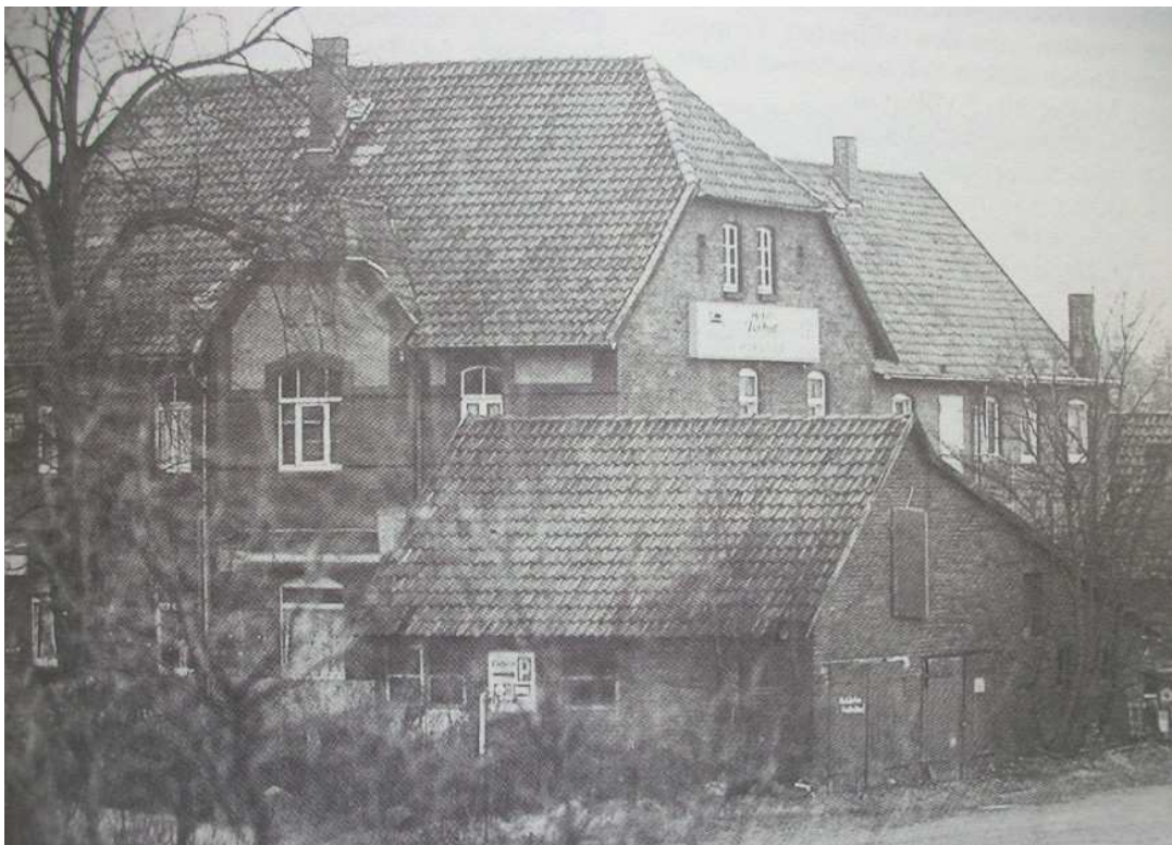
Gasthof Göhns – in einem Anbau waren Kriegsgefangene untergebracht
