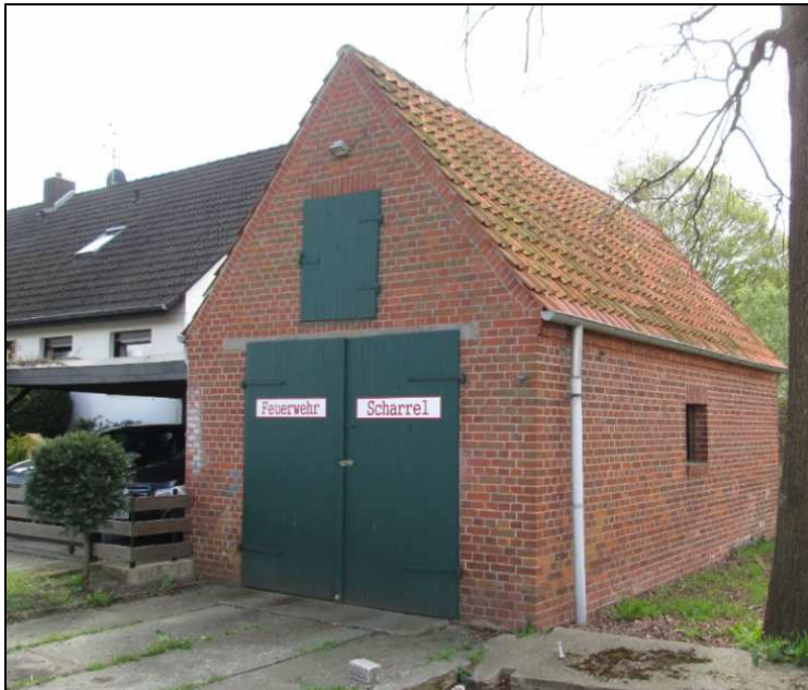
Feuerwehrgebäude in Scharrel (Bild: Stefan Weigang)
