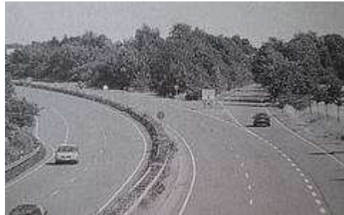
... nach der Fertigstellung
